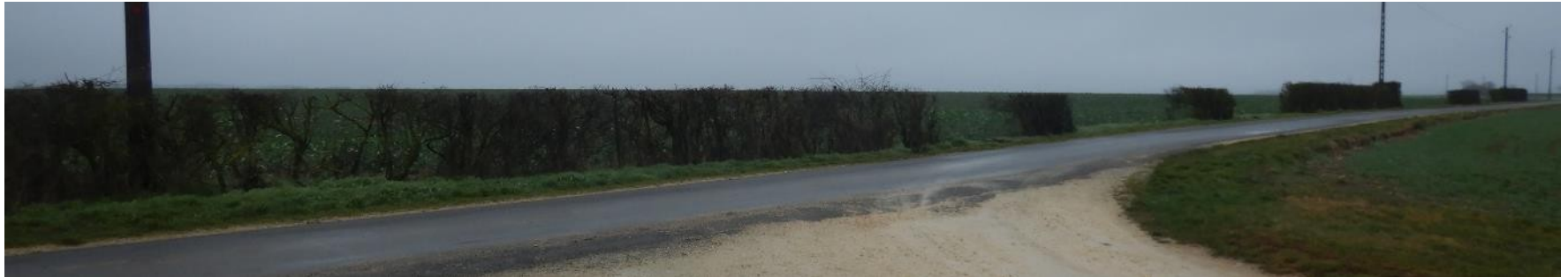
Haie arbustive pour partie détruite et compensée pour la création d'un virage d'accès
